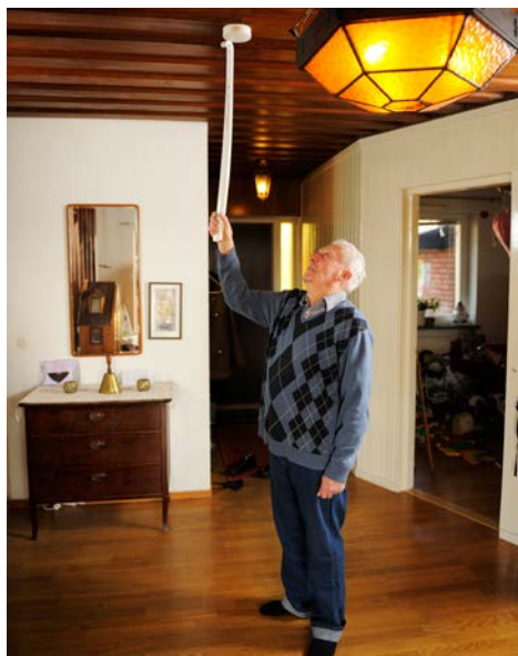
Tryck på brandvarnarens testknapp med hjälp av skohornet. Signalen är ett kvitto på att brandvarnaren och batteriet fungerar. Bild: Testhornet.
